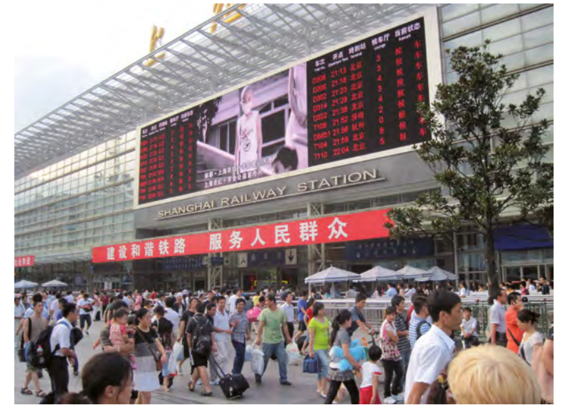
La gare centrale de Shanghai, nœud incontournable du réseau ferroviaire entre le nord et le sud de la Chine.
