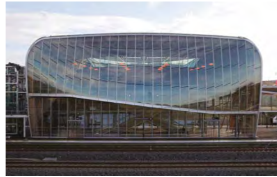
La gare Tgv de Belfort-Montbéliard associe technologie et nature.
